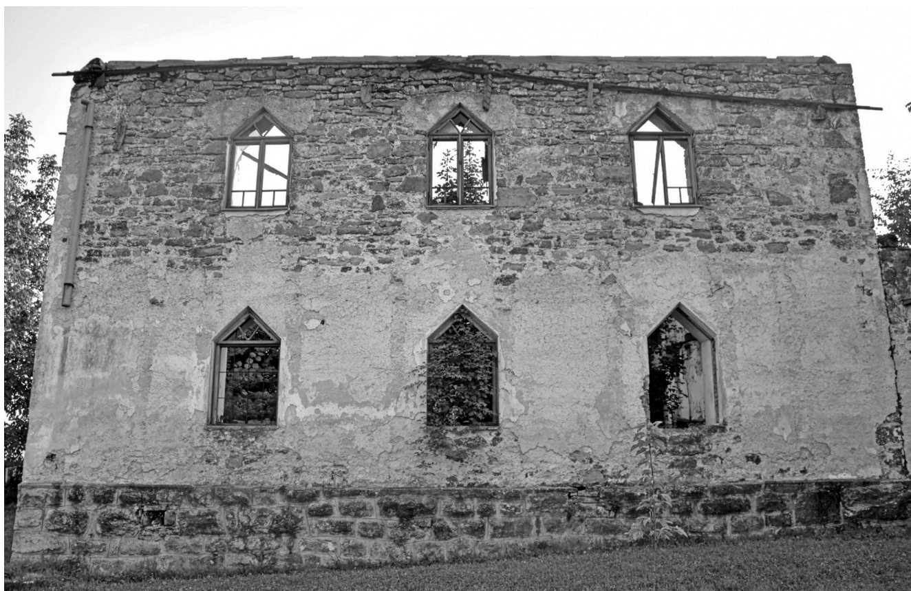
Sjeveroistočni zid Stare džamije u Lubardi (Foto: Amir Sijambodžić)
