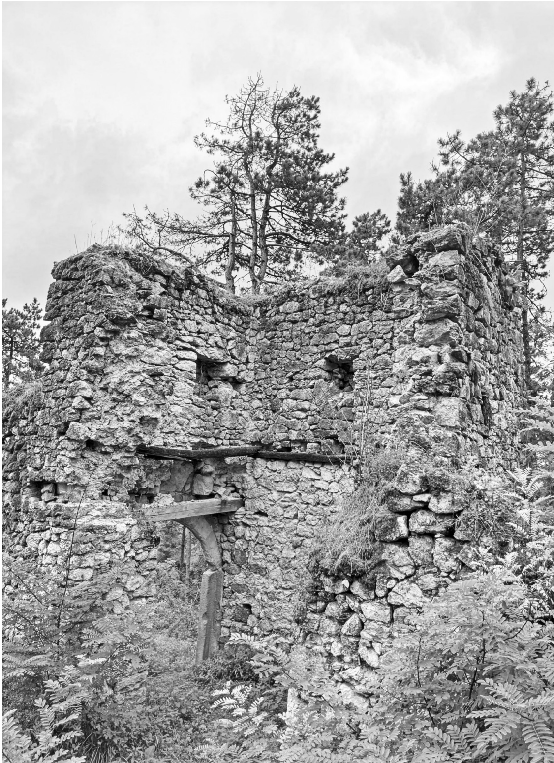
Kapi-kula i prostor gdje se nalazila drvena džamija u tvrđavi u Podzvizdu (Foto: Haris Suljadžić)
